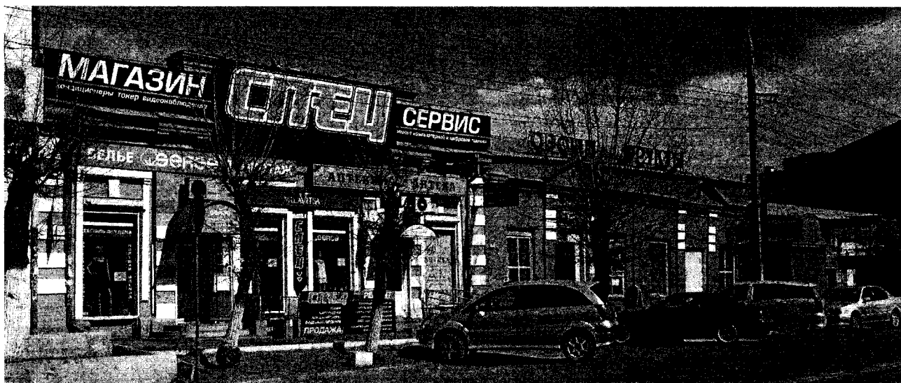
Фото 1. Главный юго-западный фасад (вид с улицы Амурская, 09.04.2018 г.)
